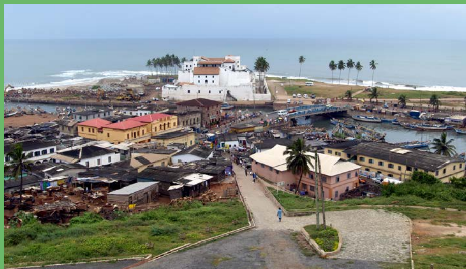
Fort St George te Elmina vanaf de zee- en de landzijde.
